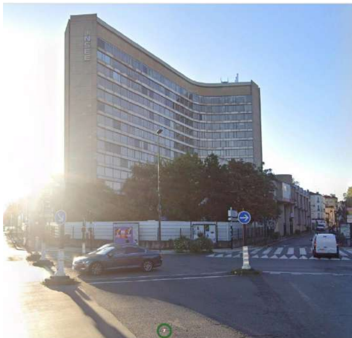
Avant la démolition : vue depuis l'angle nord-ouest du bd Pinard
