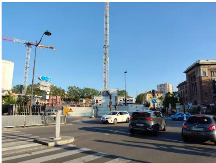
vue des travaux depuis l'angle nord-ouest du bd Pinard avant l'été
