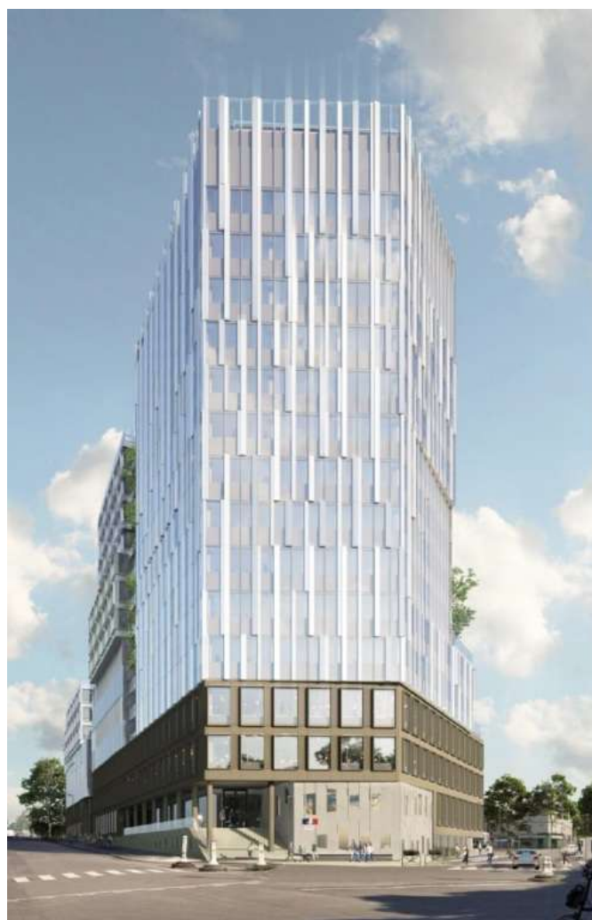
Projet : même vue après les travaux
